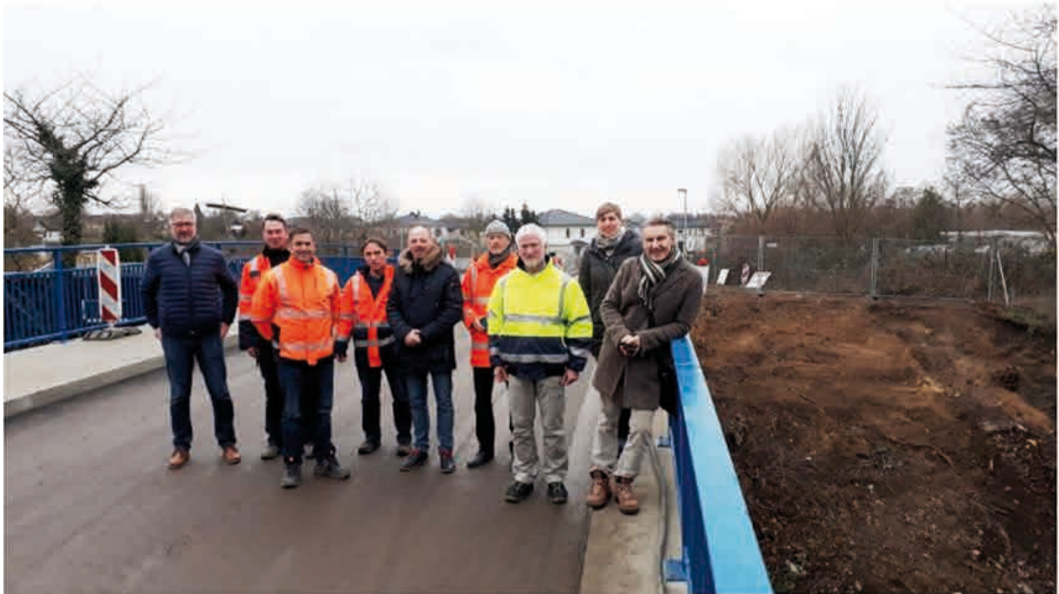
Nach zehn Monaten fertig – die Bahnüberführung im Verlauf des Gosewinkler Weges. Foto: Landeshauptstadt Schwerin
